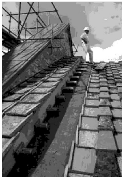
Fig. 10 - Connexions en alliage à mémoire de forme posées entre le tympan et le toit de la Basilique (d'après [3]).
